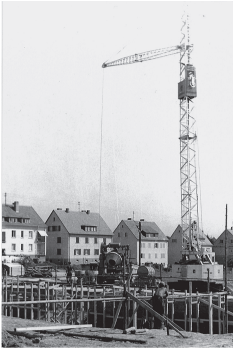
Neubau Haupt-/Realschule Usingen
